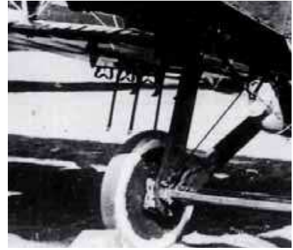
Detalle de las abrazaderas y correajes de las bombas bajo el ala del DH.4 - SHYCEA.
