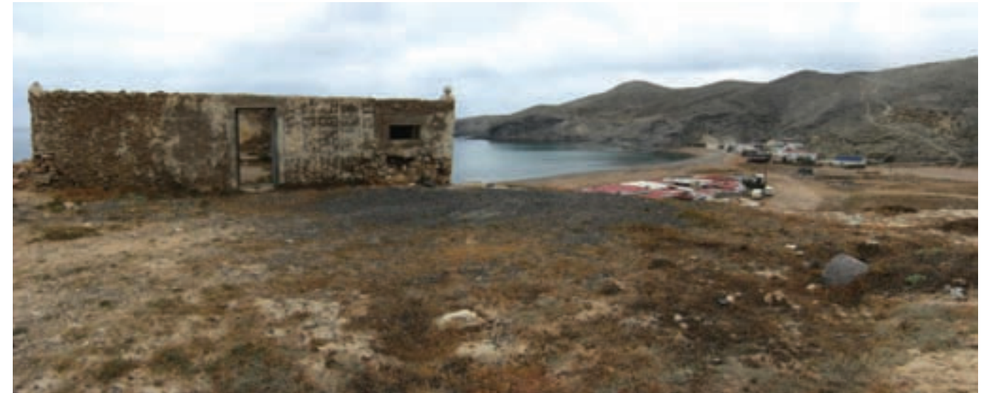
(Foto 11) Sidi Boundien junto a la playa de Charranes
