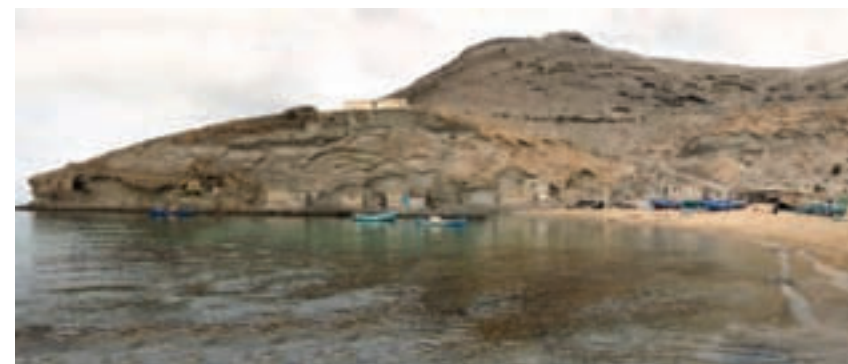
(Foto 7) Sidi Ahmed en un estado de deterioro muy avanzado sobre el acantilado.
