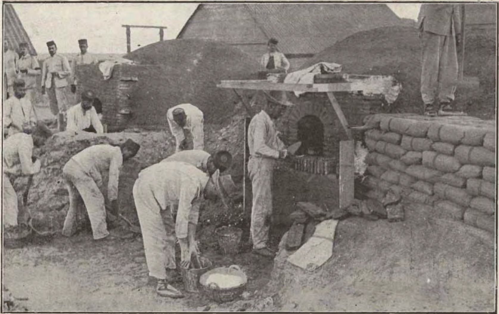
SOLDADOS DE INGENIEROS CONSTRUYENDO HORNOS DE CAMPANA PARA LA COCCION DEL PAN EN EL FORTÍN DE LA RESTINGA
