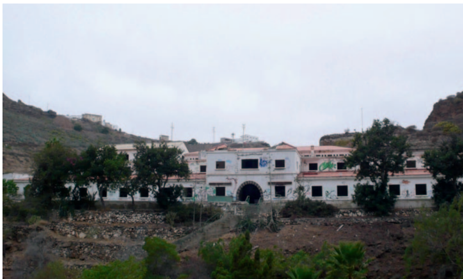
Estado actual del abandonado cuartel de Guanarteme
