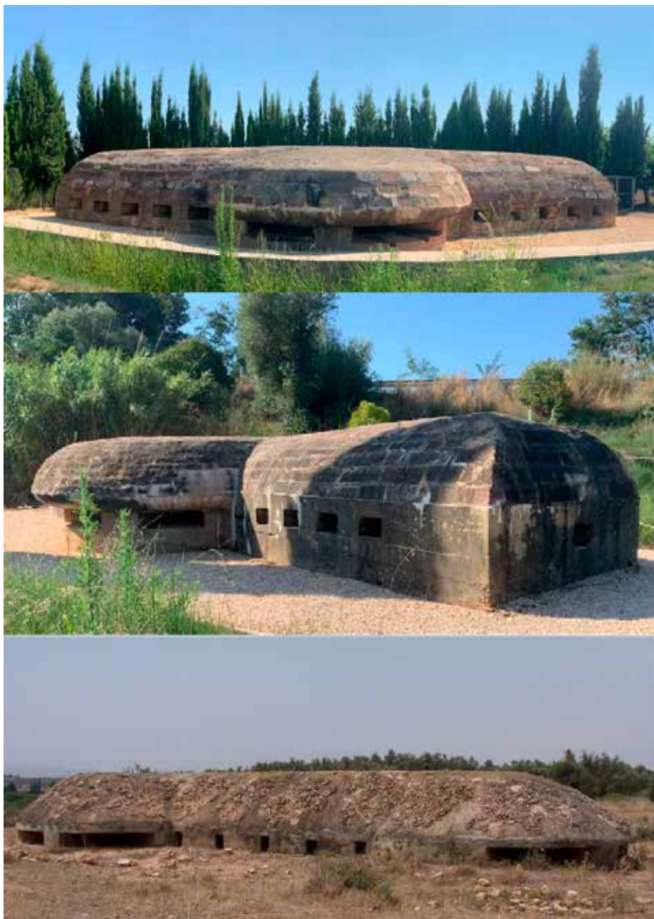
Arriba y centro: Estado actual de los fortines n.º 3 y 4 de Nules; fotografías del autor. Abajo: Uno de los fortines del Muluya; fotografía gentileza de Santiago Domínguez Llosá
