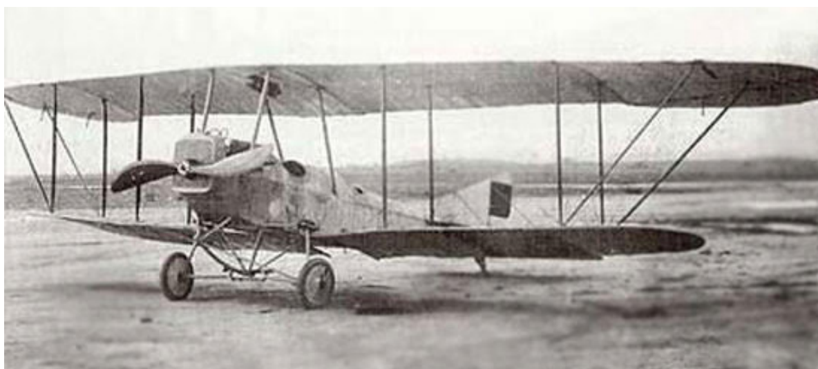
Barrón W con el que se efectuaron las primeras pruebas de radiotelefonía aérea en Cuatro Vientos
