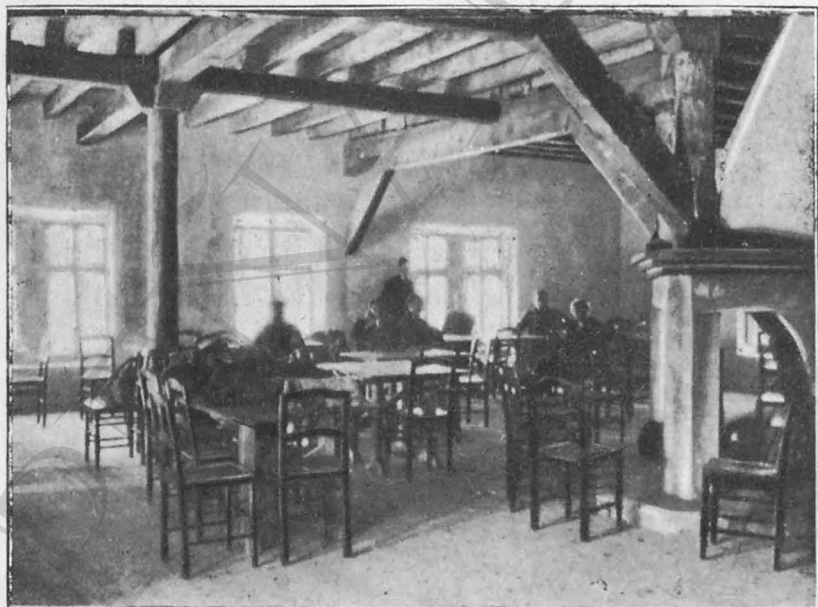
NUESTRO ALBERGUE DE LA FUENFRÍA. Aspecto exterior. — Vista parcial del comedor.
