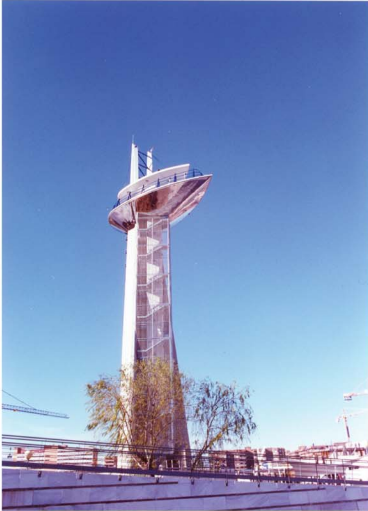
TORRE PARQUE DE LAS CIENCIAS GRANADA
