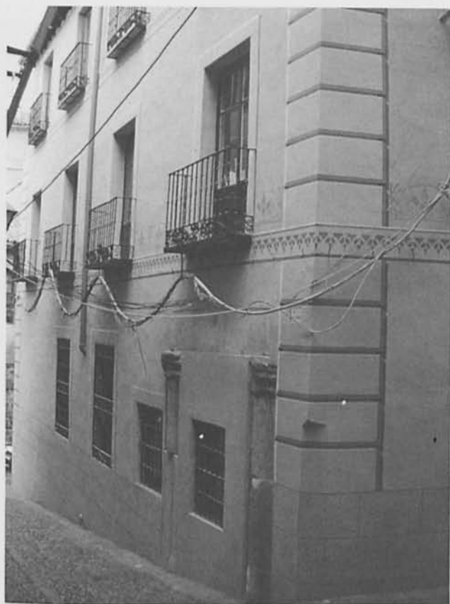
Fig. 6. Cables colgando en una fachada recién restaurada.
