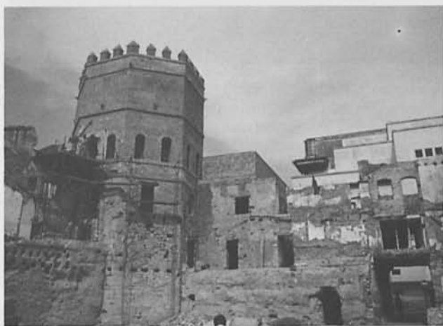
Fig. 6. Consolidación y eliminación de adosamientos en la Torre de la Plata.
