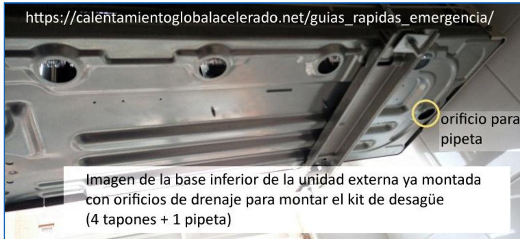
Imagen: Todos los orificios de drenaje son iguales pero uno de ellos, el más cercano a la pared, será en el que montaremos la pipeta de desagüe que marcará el nivel de drenaje del agua (ingeniería romana básica)
