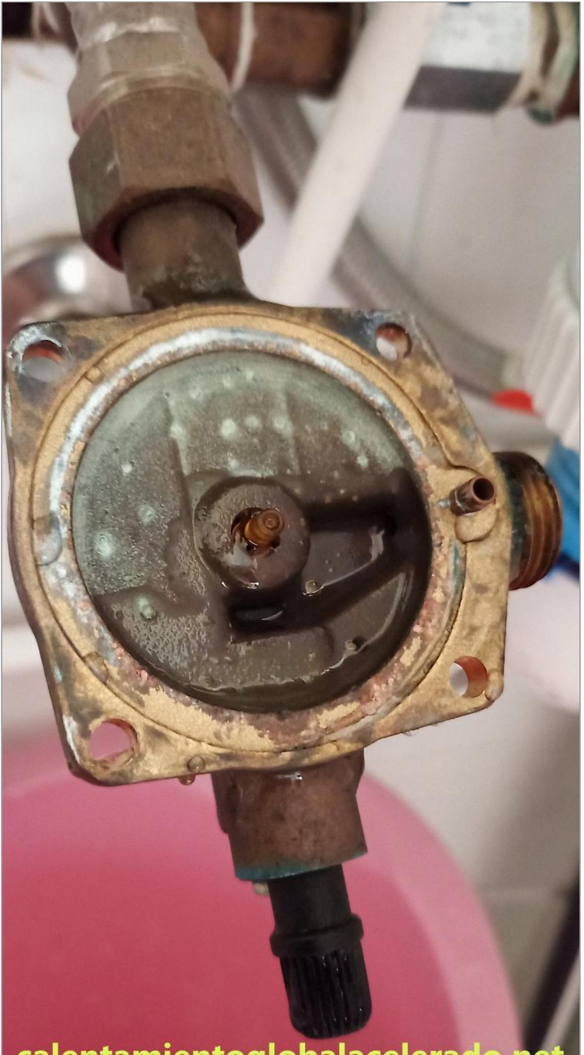
Una vez abierto el cuerpo de agua, ni siquiera es necesario que desmontemos la salida de agua del mismo (en la zona superior de la fotografía anterior), ya que será suficiente con desenroscar la tuerca que fija el tubo de entrada de agua al cuerpo (a la derecha en la foto anterior) y los 4 tronillos que unen ambas partes del cuerpo para poder extraer y sustituir la membrana de agua de nuestro calentador.
