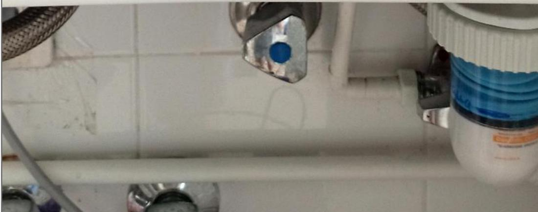
El vaso de la parte inferior derecha de la imagen en un filtro de polifosfato que evita la formación de piedra al reducir la dureza del agua.
