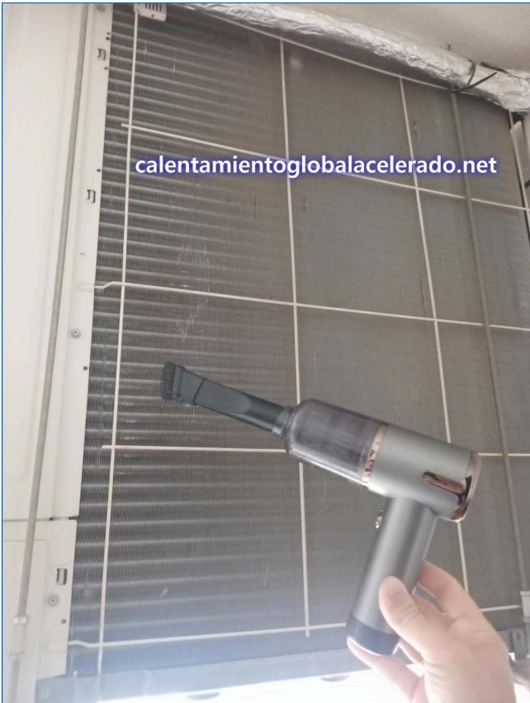
El uso de la boquilla de cepillo es IMPRESCINDIBLE para no dañar los filamentos metálicos del radiador:
