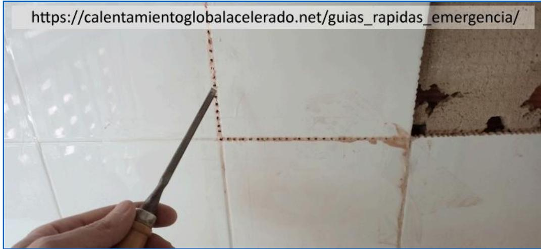
Imagen: Con el formón lo que hacemos básicamente es seguir la línea de calados y repasarla con fuerza para conseguir cortar la cinta adhesiva y también romper un poco la masilla de la junta. Aunque en la imagen apenas se aprecia, todo el paño de azulejos en el que voy a trabajar está "cosido" literalmente por cinta adhesiva transparente que cubre todas las juntas.
