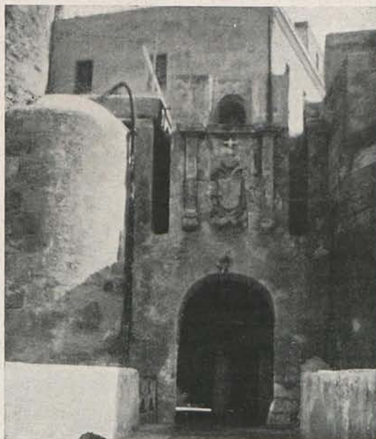
Puerta de salida al foso
