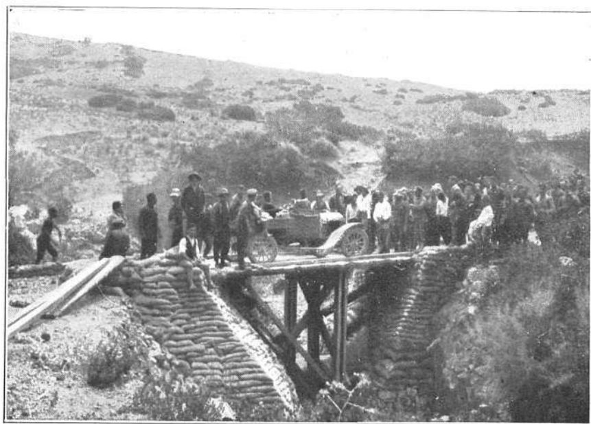
Soldados de Ferrocarriles habilitando un pontón.
