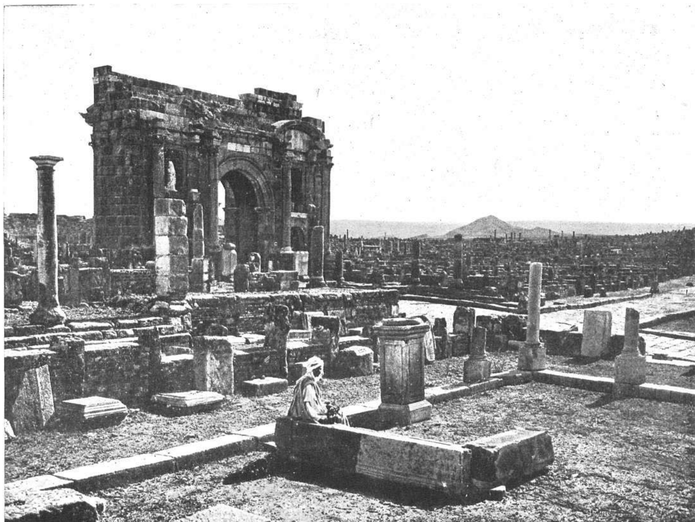
TIMGAD (Túnez): Vista general; en primer término el Arco de Trajano
