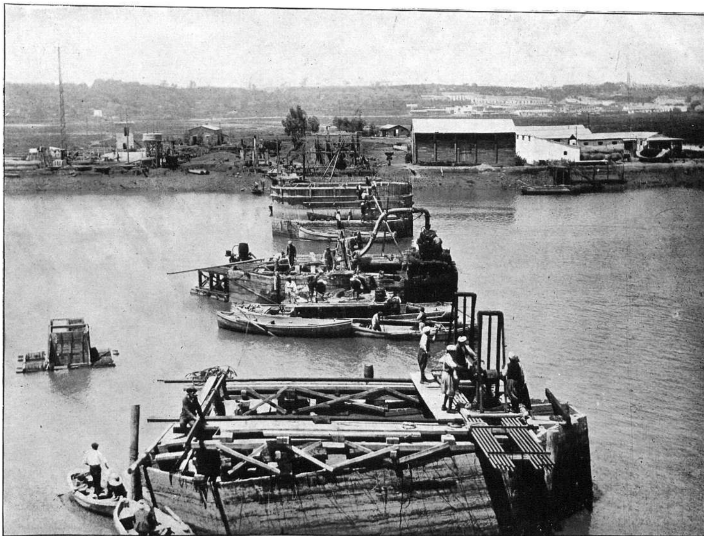
Trabajos de cimentación de las pilas, en 1927
