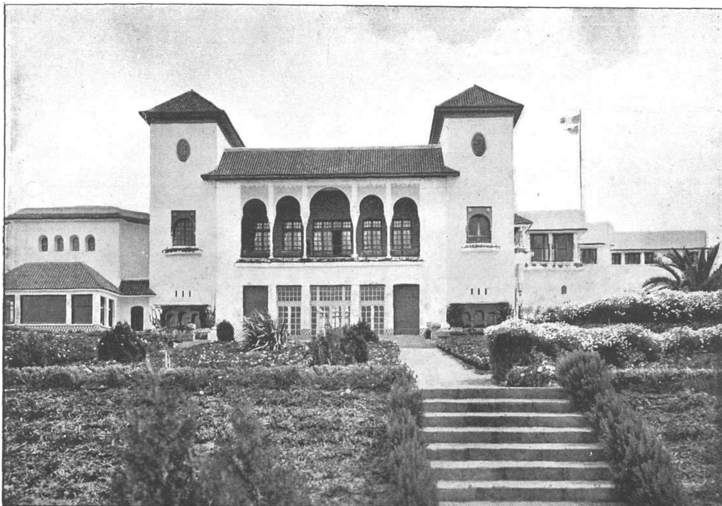
Urbanización en la zona francesa.—Barrio administrativo de Rabat.—Residencia.
