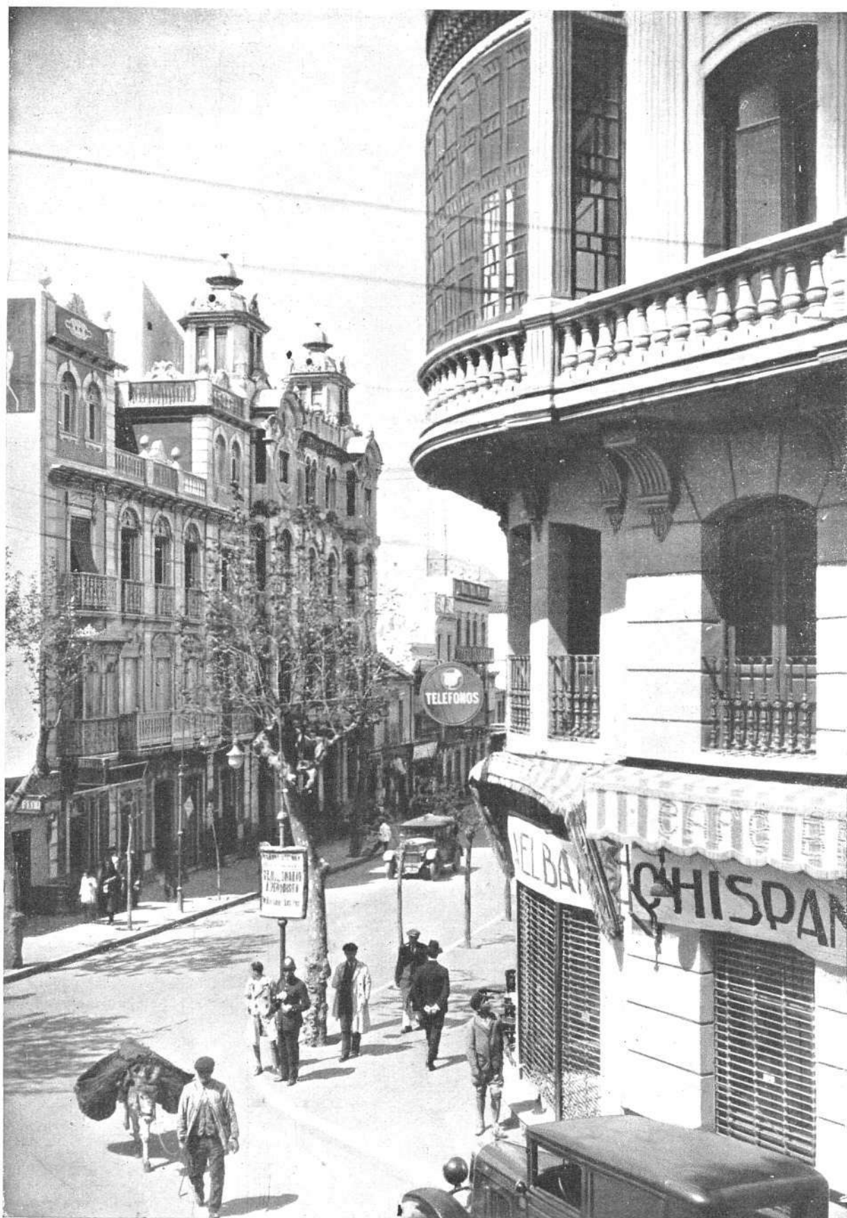
Aspecto de una vía principal de Ceuta
