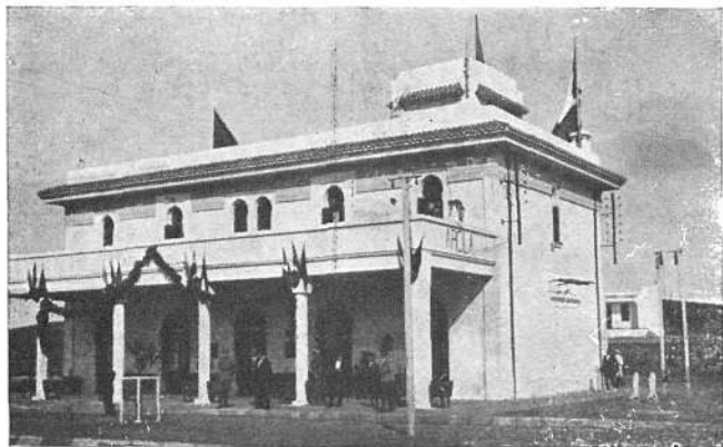
Estación de Arzila
