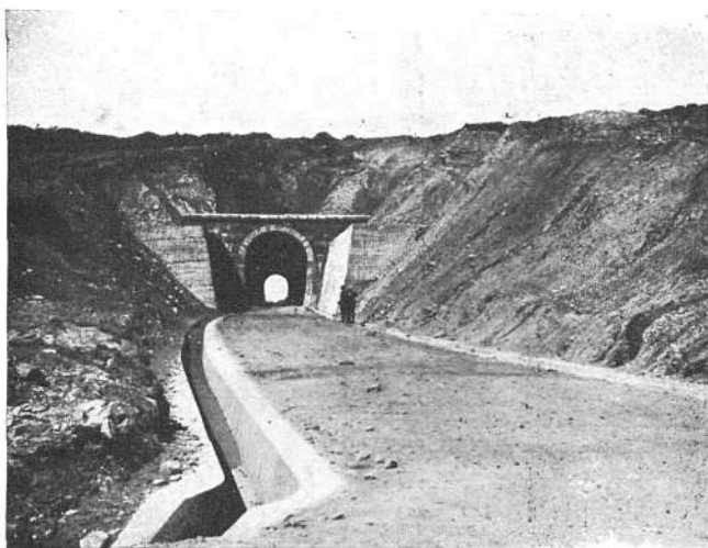
Acceso a un túnel que se corrió en gran parte y que exigió costosas obras de consolidación
