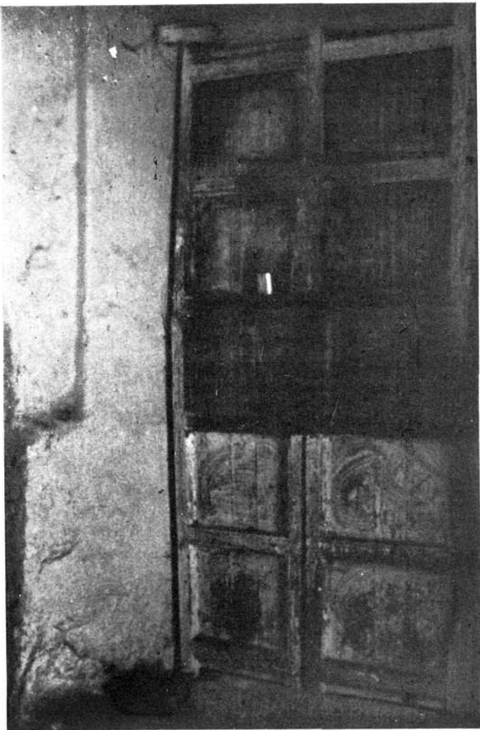
Parte exterior de la puerta de entrada, frontera a la de la Mezquita de Sidi-Saidi, del patinillo oratorio que guarda los restos del Flamenco Barón de Riperdá.
