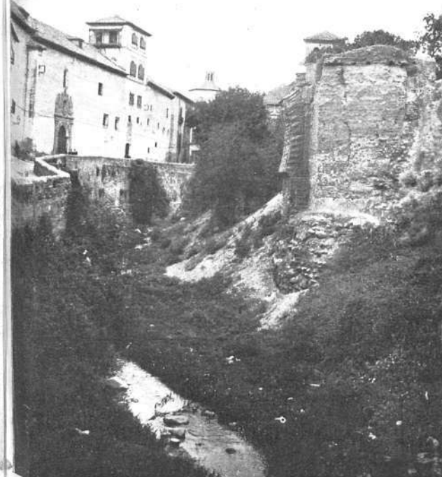
Restos del puente de Cádiz
