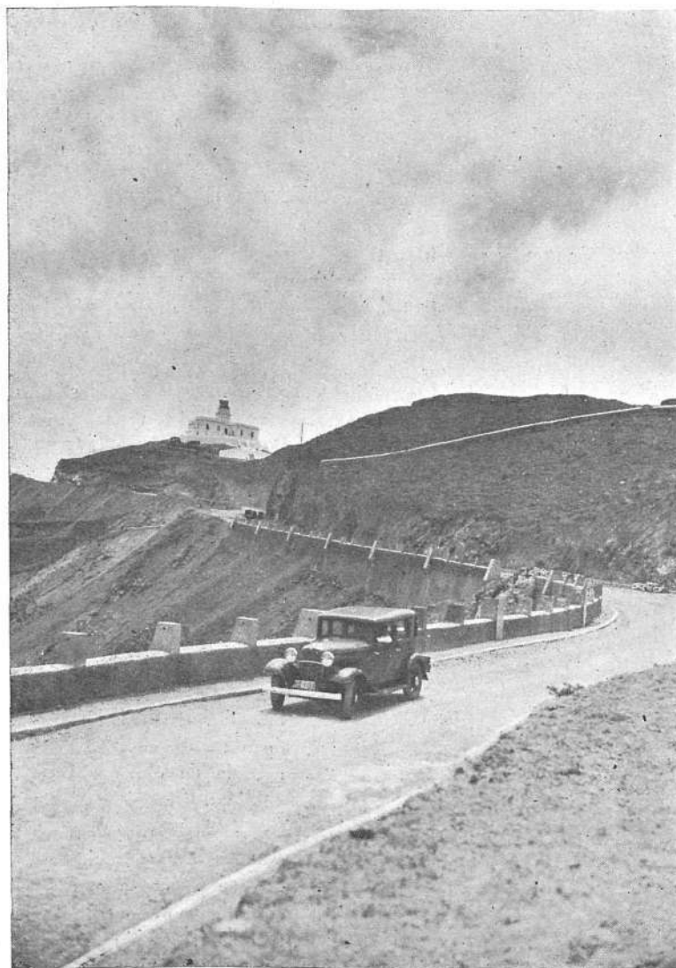
Nueva carretera de circulación del Hacho
