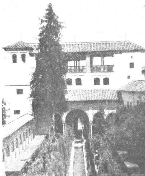
El patio de la Acequia
