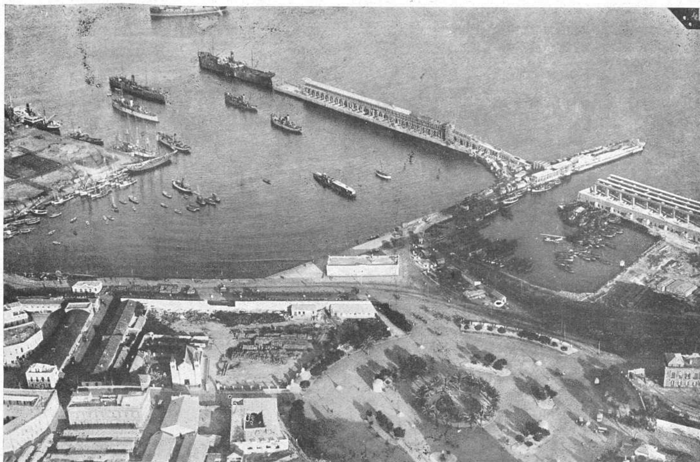
Un aspecto del puerto de Melilla con los cargaderos de mineral
